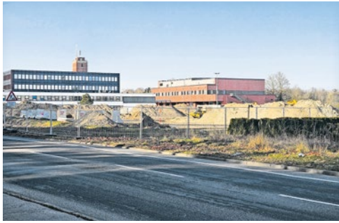
► Die Bauarbeiten an der Feuerwache gehen planmäßig voran.
