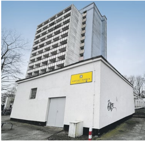
► Blick auf den Anbau vom Hochhaus Ziolkowskistraße 11, den die Schützengesellschaft Concordia jahrelang gemietet hatte.
