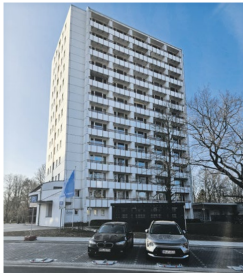
► Die Vertreter der WG Süd äußerten sich im Ortsbeirat zur Frage, ob das Hochhaus in der Ziolkowskistraße 11 erhalten werden kann oder abgerissen werden muss.
