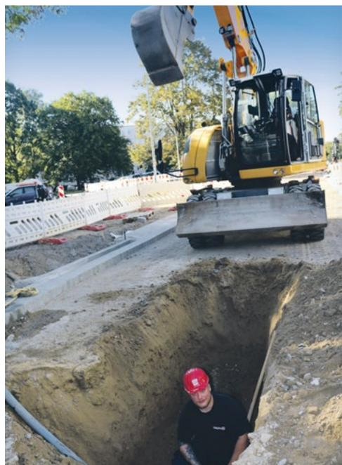
► Der zweite Bauabschnitt für die grundlegende Erneuerung der Ziolkowskistraße ist schon voll im Gange. Hier bereitet ein Arbeiter der Firma Groth den Anschluss der neuen Trinkwasserleitung vor.
