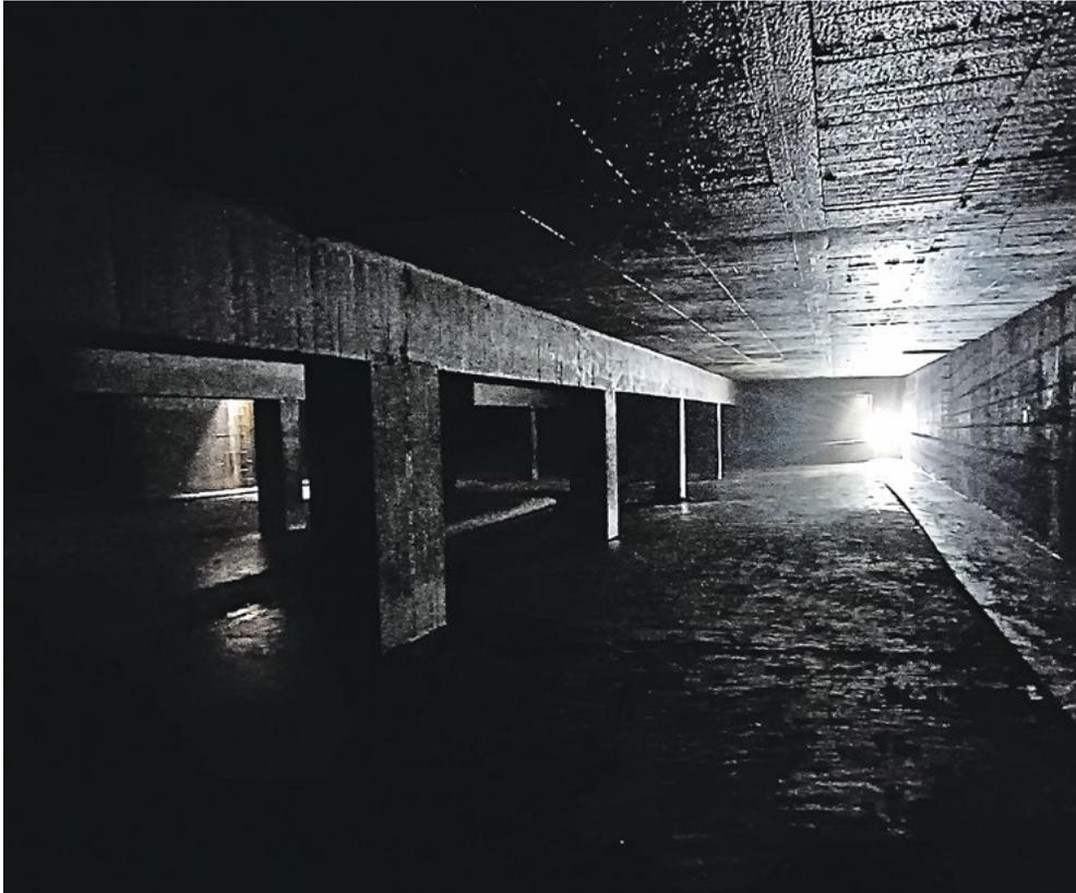
► Blick in die rund 4000 m<sup>3</sup> fassende Regenwasserrückhaltehalle unter dem Kesselborn
