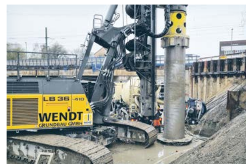
► Bohrungen im April für den Wiederaufbau der Brückensüdseite.
