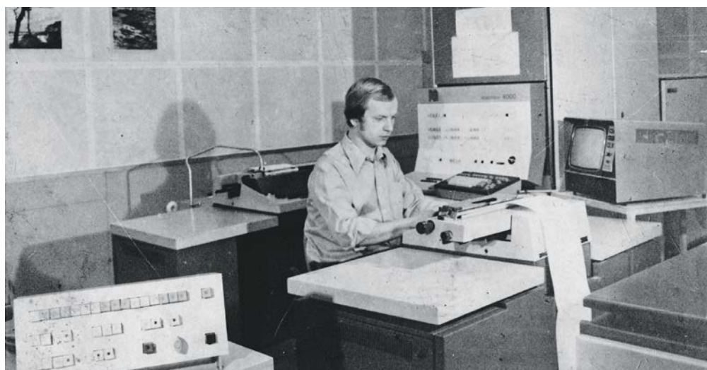
► Im Rechnerraum des Stellwerks B 1 arbeitet Dietrich Lindner im Jahr 1977 an einem Robotron-Prozessrechner
