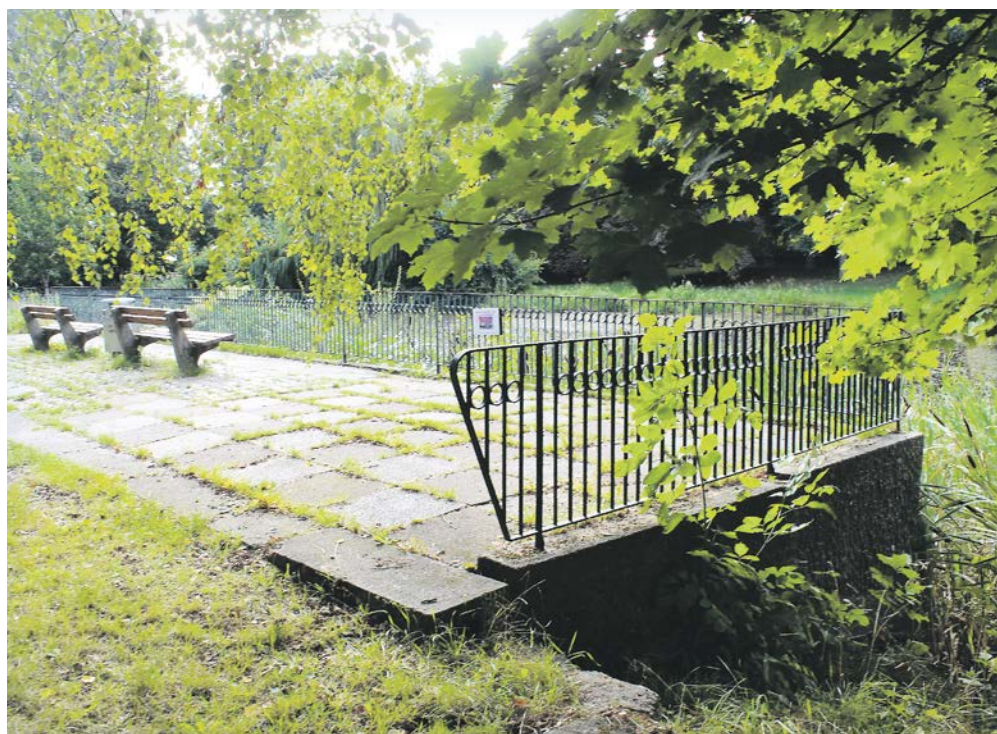
► Die Aussichtsplattform am Kringelgrabenteich soll saniert werden.
