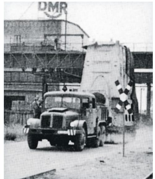
► Transport einer Motorensektion zur Werft, auf Culemeyer-Schwerlasttransportanhänger gezogen von Tatra 141
